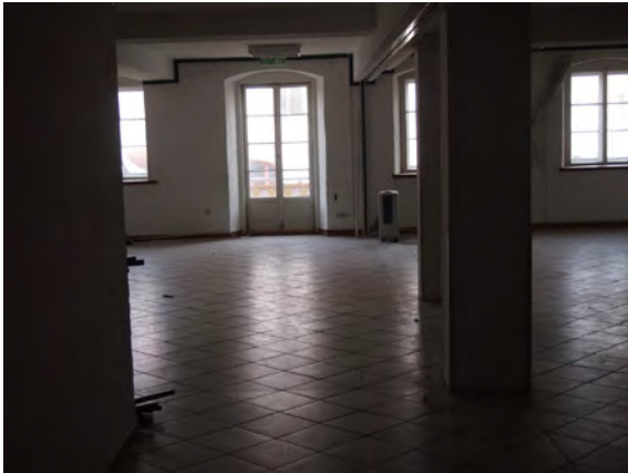
niedrige Raumhöhen im 1. OG
