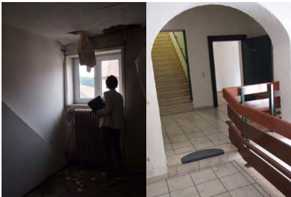
hohe Brüstung im 1. DG / Treppenhaus
