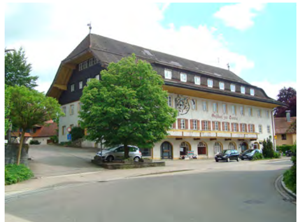
Blick von Nordost
