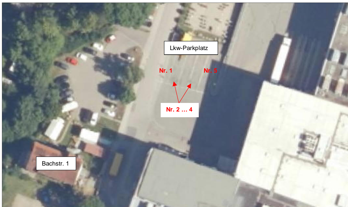
Abb. 1: Luftbildperspektive auf den bestehenden Lkw-Parkplatz (5 Stellplätze, von West nach Ost nummeriert) sowie das Anwesen "Bachstraße 1" [Quelle: BayernAtlas]
