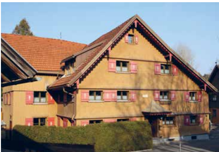
Tannenfelsstraße 4 in Heimenkirch, sog. „Katzmühle, Zweiseithof mit Holzvertäfelter Fassade und Klappläden
