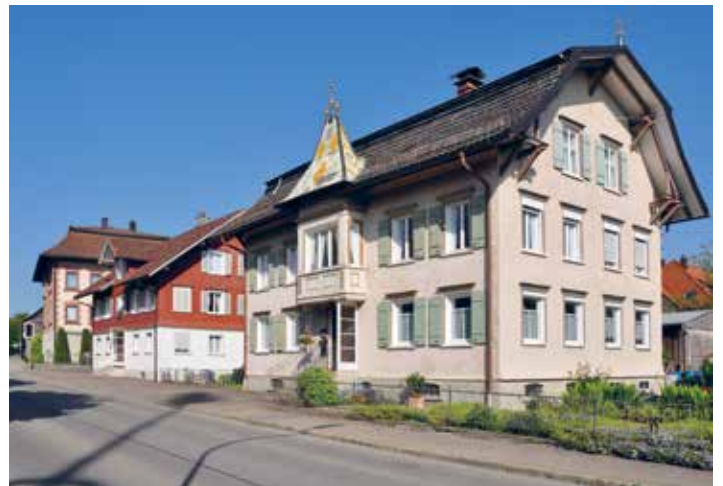
Bodenseestraße in Opfenbach mit traufständigen Gebäudestellungen
