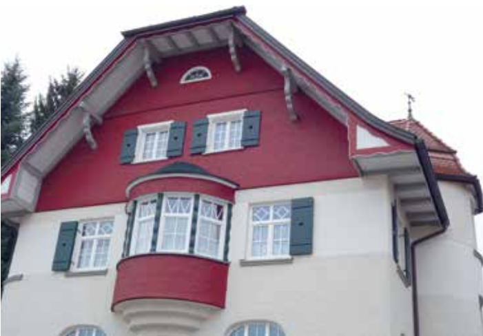
Kemptener Straße 24 in Heimenkirch, villenartiges Wohn- und Geschäftshaus, um 1900, asymmetrisch gegliedert, mit weiten Vordächern und Erkern
