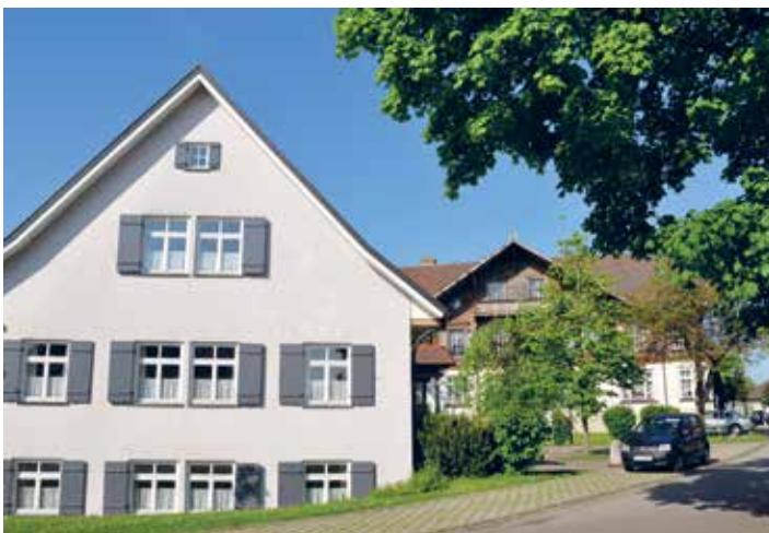
Kirchplatz 4 in Opfenbach, St.-Anna-Haus, ehem. Benefiziatenhaus, verschindelter Satteldachbau
